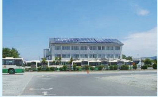
太陽光パネル（奈良営業所屋上）
